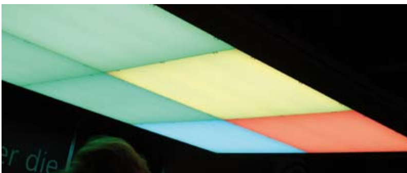
CIELOS – die neue Generation der Lichtdecke: mit 80mm Anbauhöhe die niedrigste mehrfarbige Flächenleuchte auf dem Markt
