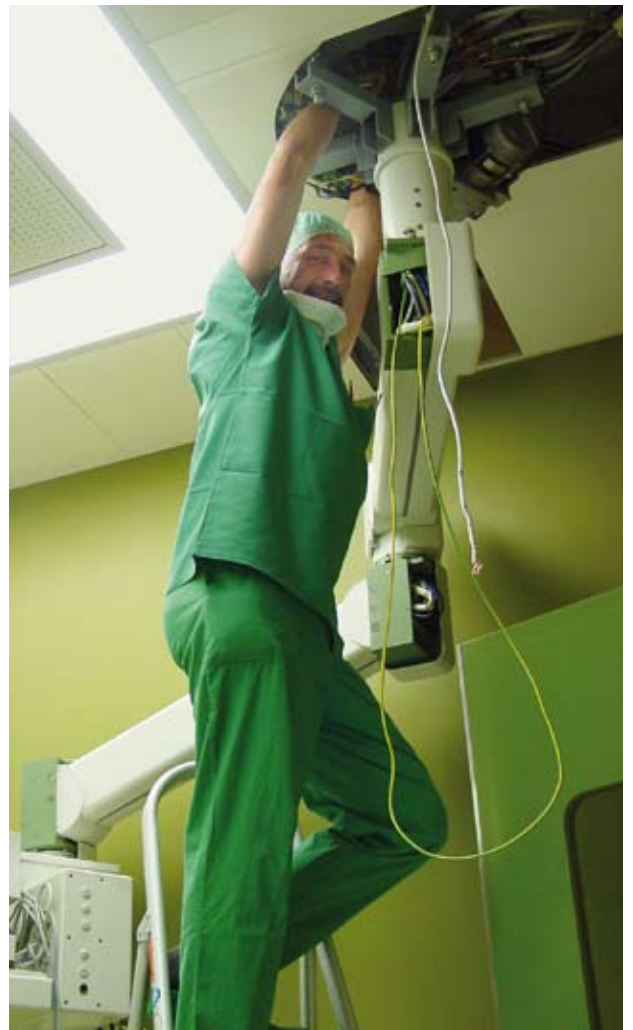
Günter Rosshart beim Kabeleinzug für die ZPA-Buchsen im Deckenpendel
