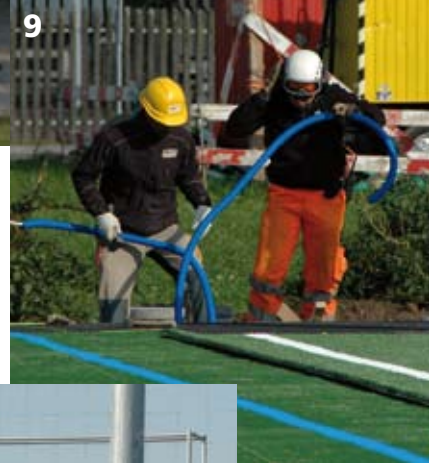
Währenddessen werden Rohre und Kabel am nächsten Standort vorbereitet.
