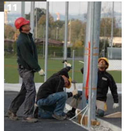
Doch dann stehen sie alle, die Kabel sind eingeführt und die letzten Holzkeile werden reingeschlagen.
