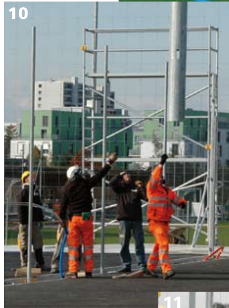
Der Kandelaber ist wegen Wind und langem Seil nicht leicht zu fassen und am richtigen Ort zu platzieren.
