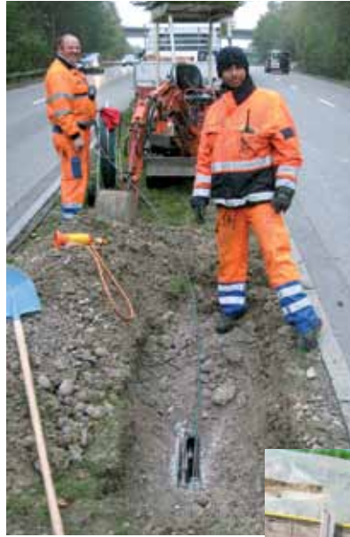
LWL Kabeleinzug für die Wasserversorgung Zürich und an einer Hochleistungsstrasse
