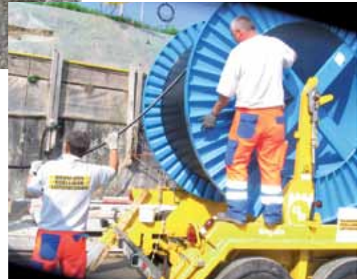
LWL Kabeleinzug für die Wasserversorgung Zürich und an einer Hochleistungsstrasse
