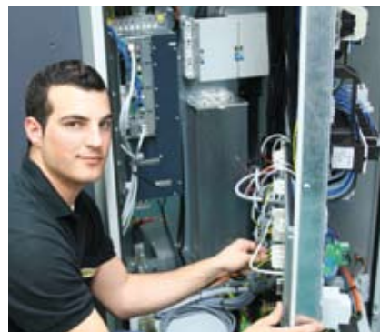
Kontrolle der Anschlüsse durch Projektleiter David Calò
